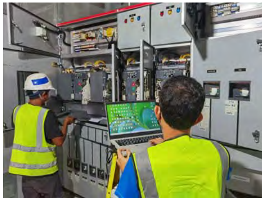
Photo 12-13-14-15-16-17-18-19 : ภาพแสดงการทดสอบ Air Circuit Break ขณะทำ Preventive Maintenance
