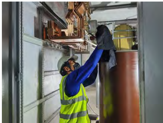
Photo 8-9-10-11 : ภาพแสดงการทำความสะอาดและทดสอบ หม้อแปลงขณะทำ Preventive Maintenance
